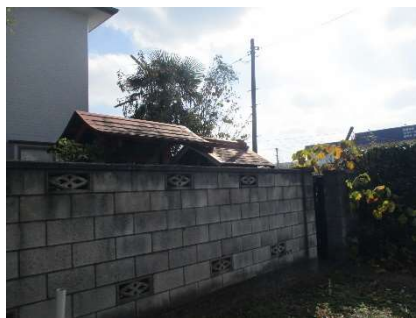
手水舎と大師堂の屋根 (道路側から)
