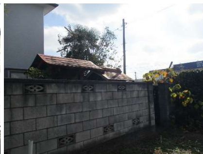
手水舎と大師堂の屋根 (道路側から)
