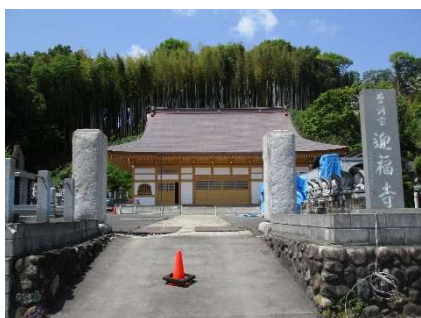
建築工事中の本堂
