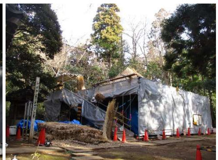
観音堂(光堂)の屋根の葺替作業
