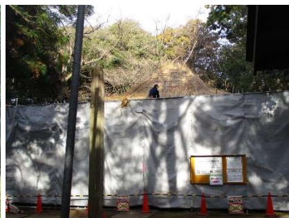
観音堂(光堂)の屋根の葺替作業
